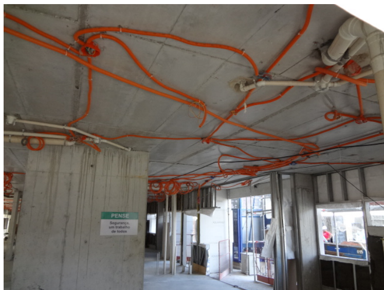
Figura 4.41 - Passagem horizontal de tubulações no entreferro. Wind Residencial.
