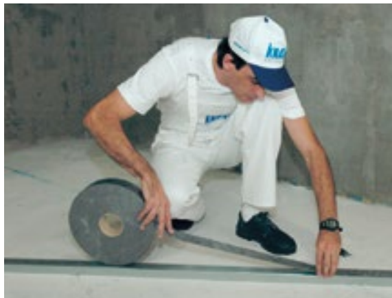
Figura 4.10 - Operário aplicando fita de neoprene à guia.
