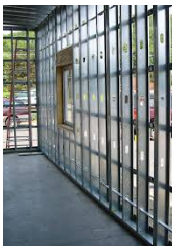
Figura 2.6 - Estrutura em steel frame
