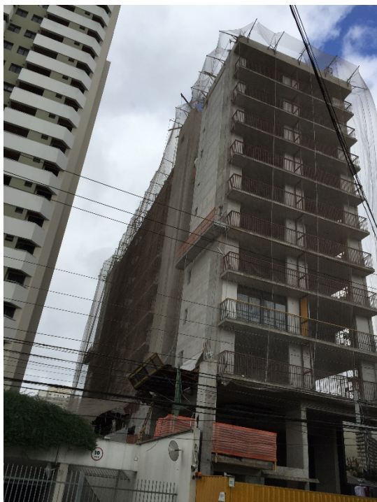
Figura 2.20 - BK30 - a) Vista Frontal. b) Pano de Fachada lateral com placas cimentícias.
