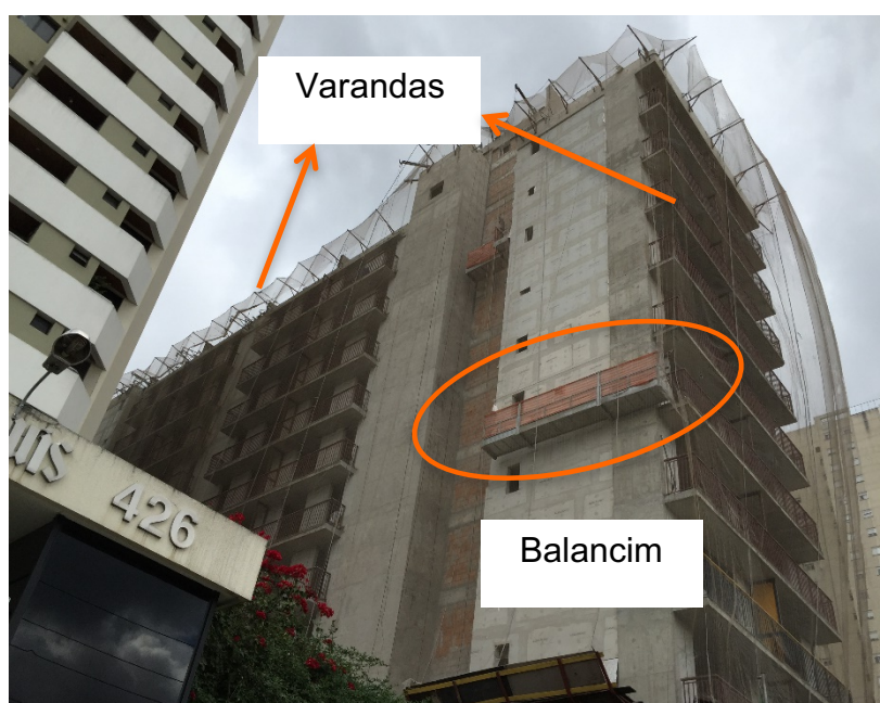
Figura 4.46 - Balancim Elétrico e varandas como plataforma de trabalho. BKO BK30.
