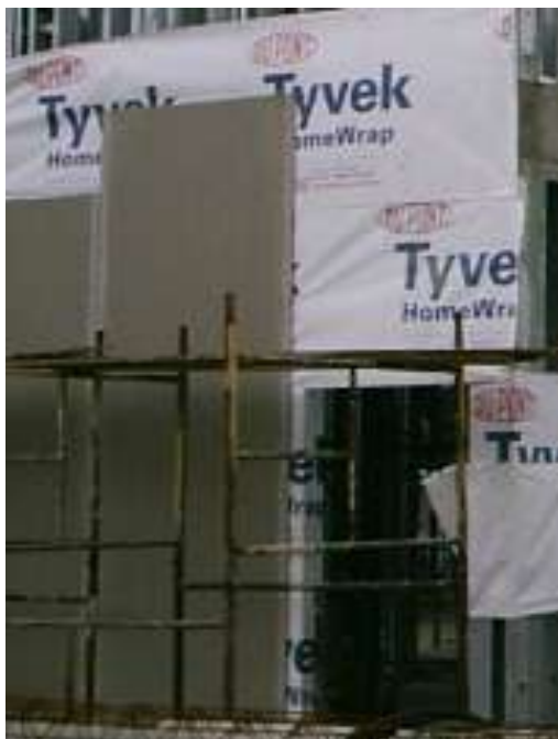
Figura 4.20 - Montagem das placas cimentícias exteriores sobre barreira impermeável.
