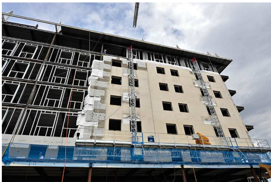
Figura 2.17 - Fachada Leve em construção - Hotel Ibis, Canoas-RS
