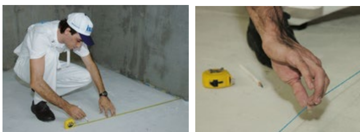
Figura 4.4 - Operário realizando locação com trena e marcação com fio de náilon.
