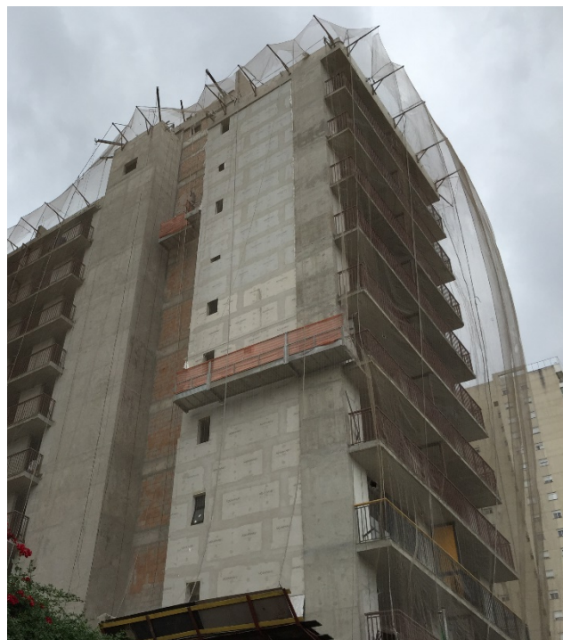
Figura 2.20 - BK30 - a) Vista Frontal. b) Pano de Fachada lateral com placas cimentícias.
