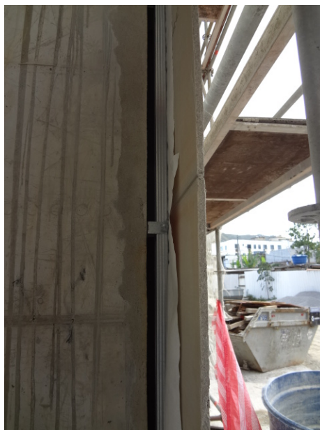
Figura 4.35 - Ancoragem e Perfil CD fixados ao pilar e placa cimentícia. Wind Residencial
