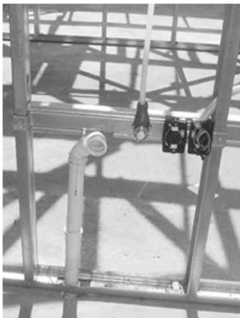
Figura 4.40 - Instalações e reforço na estrutura em steel frame .
