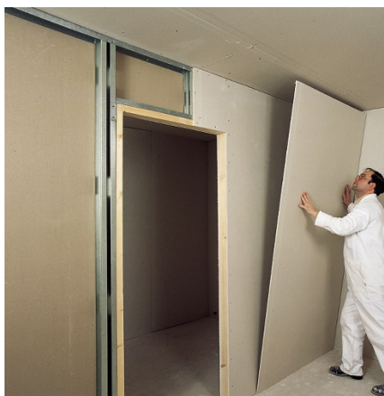
Figura 2.3- Colocação de chapas de gesso acartonado ( drywall )
