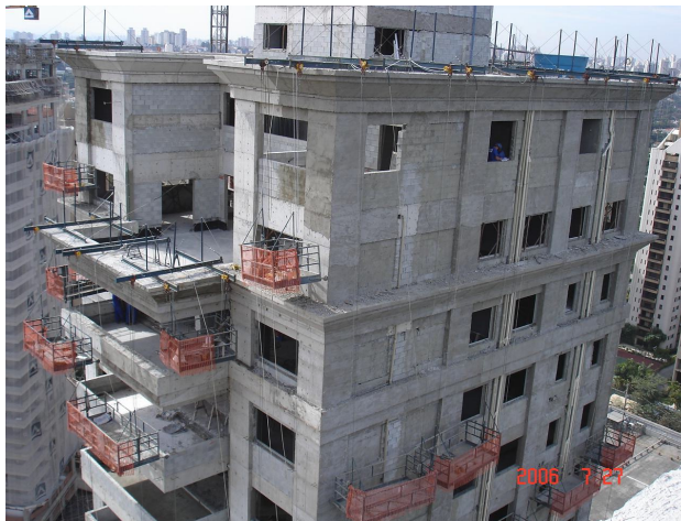
Figura 5.23 – Construção utilizando balancim na execução de revestimento de fachada tradicional
