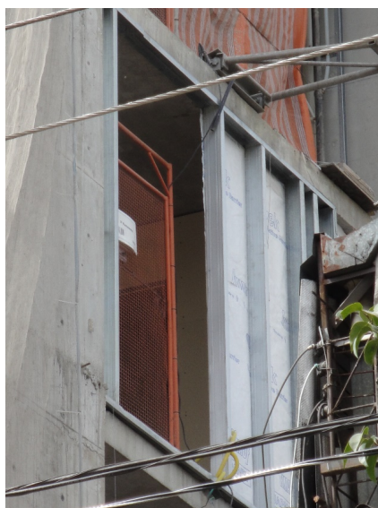
Figura 4.12 - Configuração da estrutura em steel frame instalada na obra BK30.
