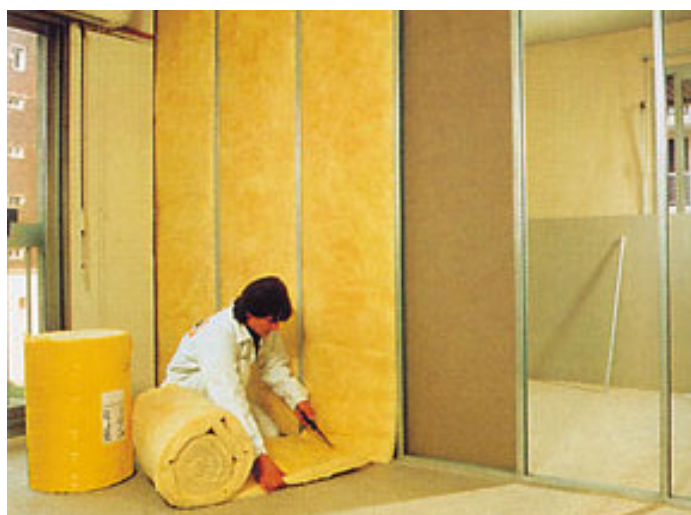
Figura 4.29 - Instalação de lã de vidro em steel frame .
