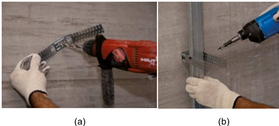
Figura 4.34 - (a) Elemento de ancoragem do perfil CD ao Pilar. (b) Fixação do Perfil CD.
