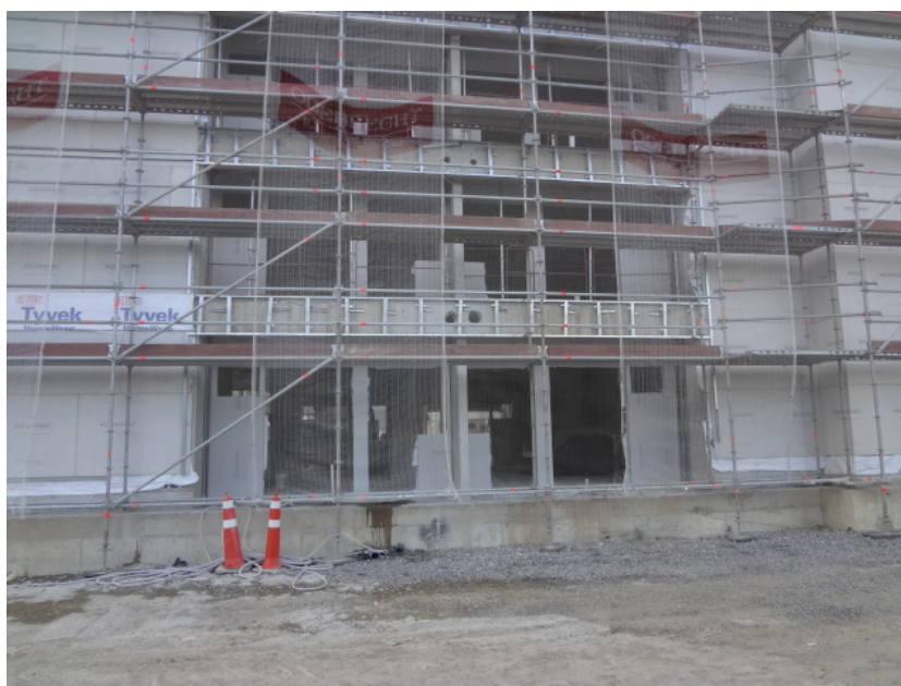
Figura 2.19 - Wind Residencial - Fechamento Externo em Placas Cimentícias
