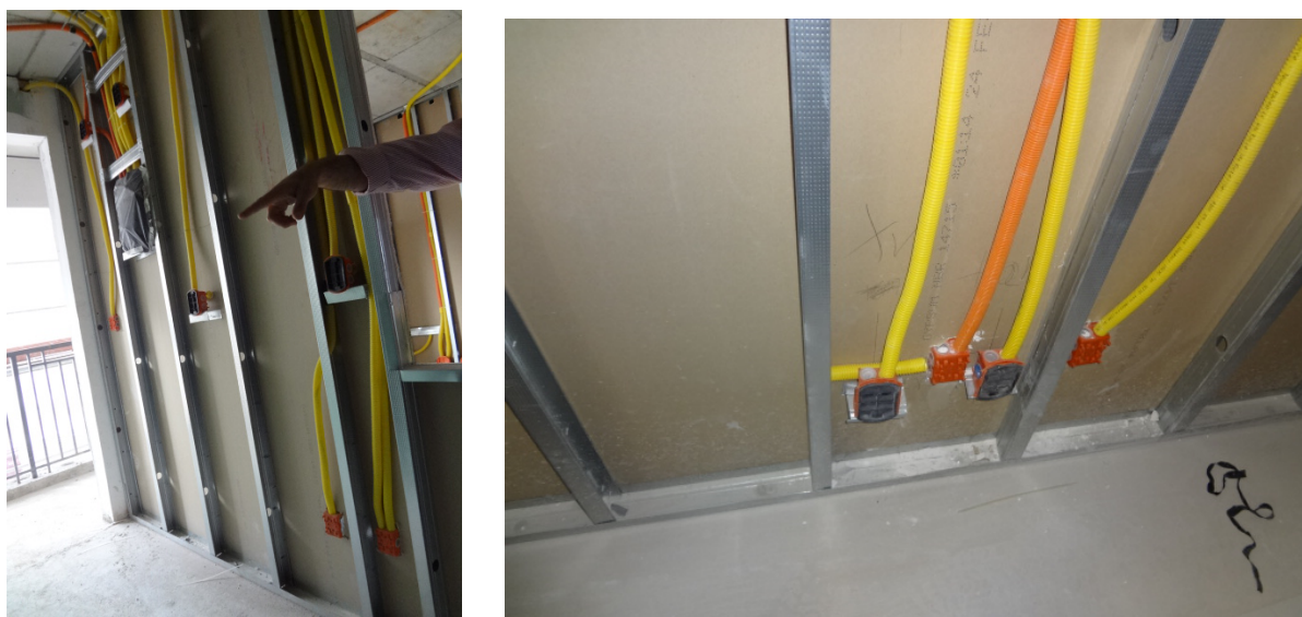
Figura 4.42 - Passagem vertical de instalações. Wind Residencial.
