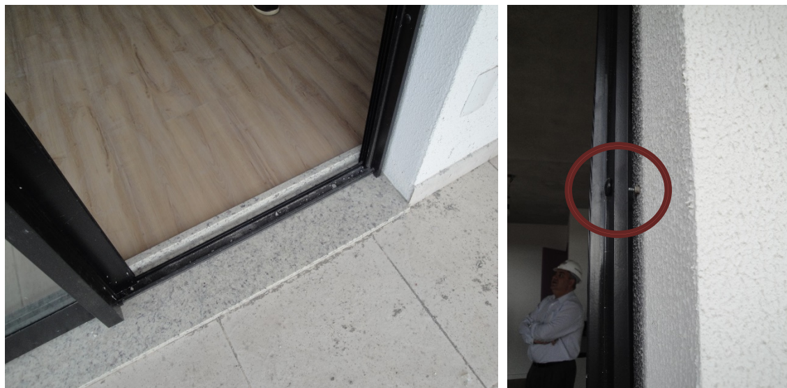
Figura 4.38 - Fixação de esquadrias. a) Fixação em soleira de granito na laje inferior. b) Fixação ao painel de fachada com parafuso e bucha. Empreendimento BKO BK30.
