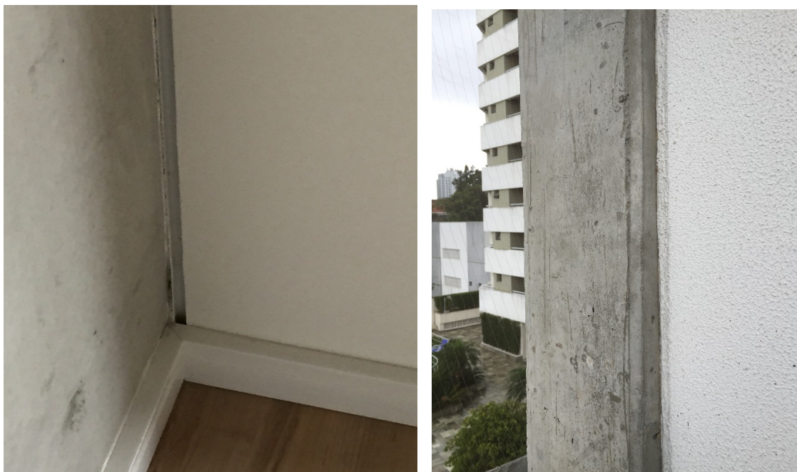
Figura 4.32 – a) Elemento em PVC para tratamento de interface entre pilar e Fachada Leve – vista do interior da unidade. b) Encontro entre pilar e painel de fachada – vista externa. Empreendimento BK30, da empresa BKO
