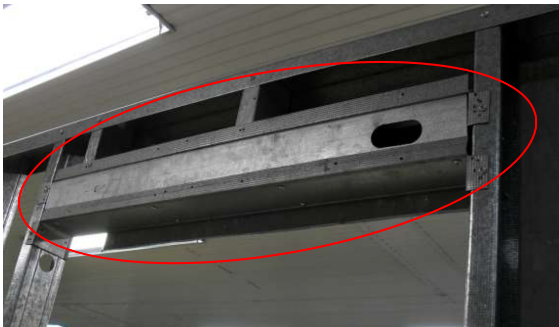
Figura 4.15 - Verga composta por dois perfis montantes encaixados, na horizontal, em perfis guia.
